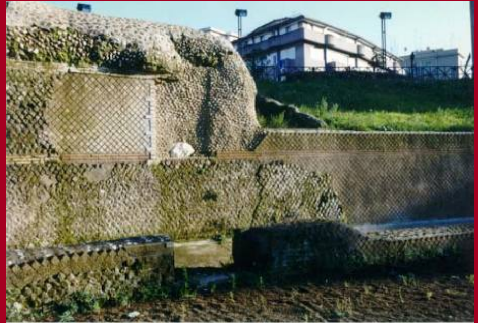
Vista dall'arena verso la parete Est del podio: si noti a destra il diverso trattamento della parete restaurata in blocchetti di tufo
