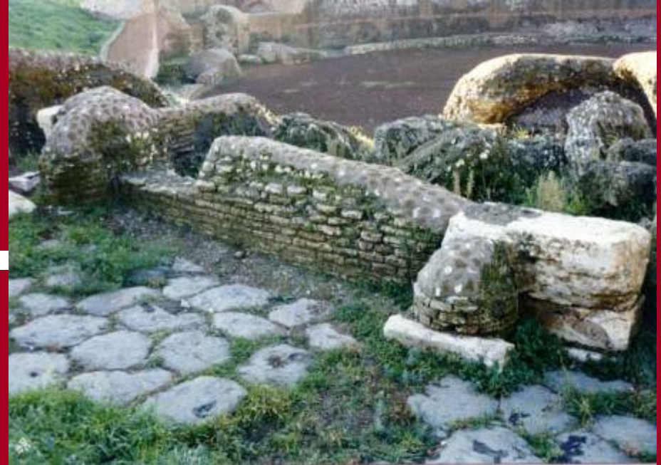
Particolare della struttura muraria dell'anfiteatro: si notino sul retro i resti crollati delle volte in conglomerato cementizio
