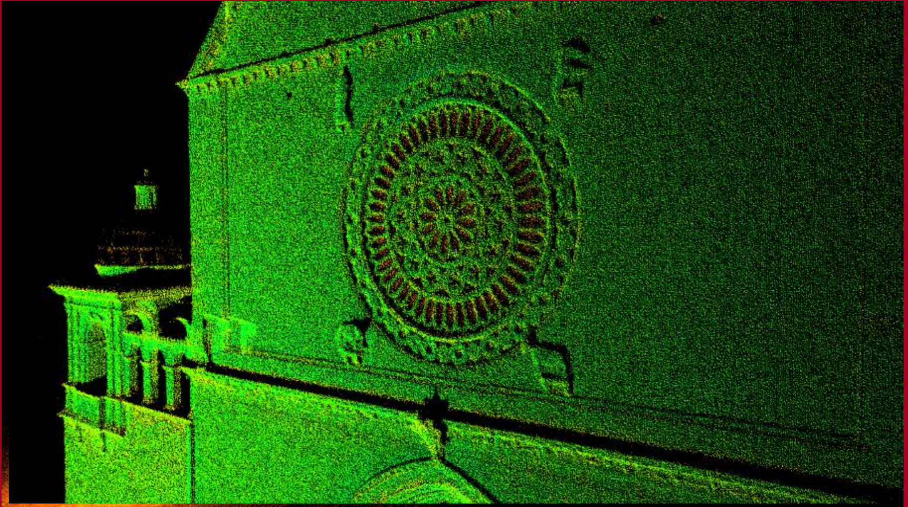
La facciata e dettaglio sul rosone
