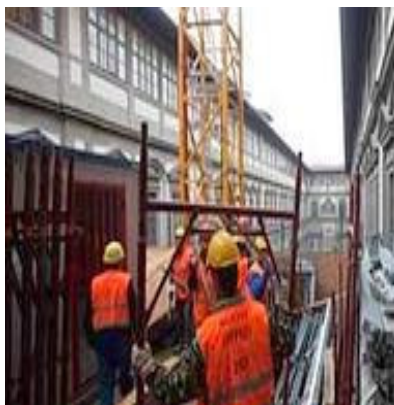
cantieri dei Nuovi Uffizi a Firenze
