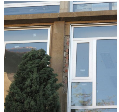
Facciata “Ala Nuova” Particolare lat. su una finestra
