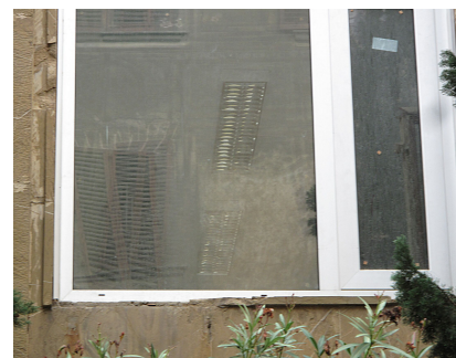
Facciata "Ala Nuova" Particolare su altra finestra
