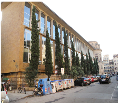
Via Magliabechi - Panoramica “Ala Nuova” da P.za S. Croce
